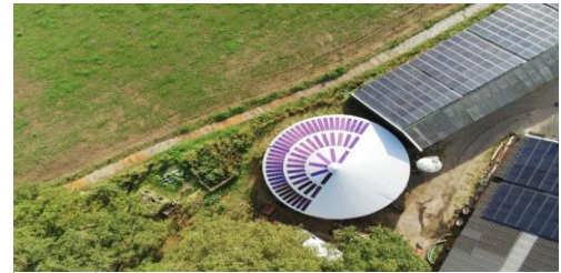
Abb. 5 : PV-Fermenterabdeckung-Blache
